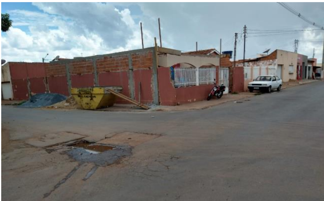
Ruas e calçadas irregulares e com obstáculos na Av. Tiradentes
