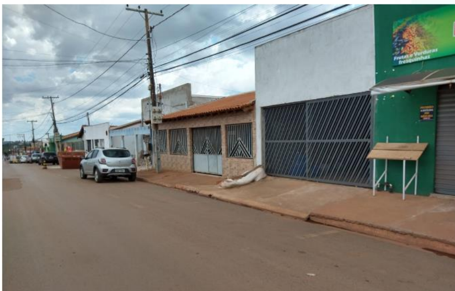
Calçadas irregulares e sem arborização na Av. Tiradentes.
